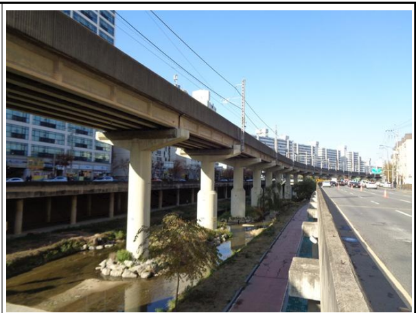
PSC구간 측면 전경
